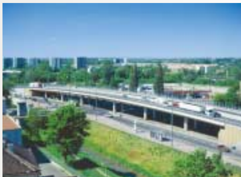
▲ Estakada w ciągu ulic Opolska-Lublańska
