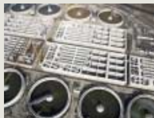
▲ Oczyszczalnia ścieków w Płaszowie
