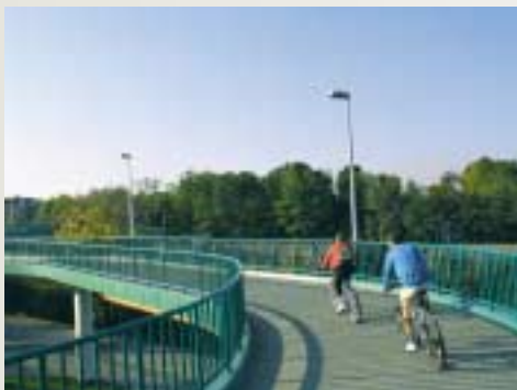
▲ Kładka pieszo-rowerowa nad ul. Powstańców Śląskich
